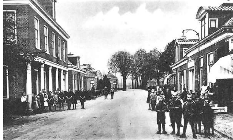
Het straatbeeld van de Voorstraat in de jaren '30.
