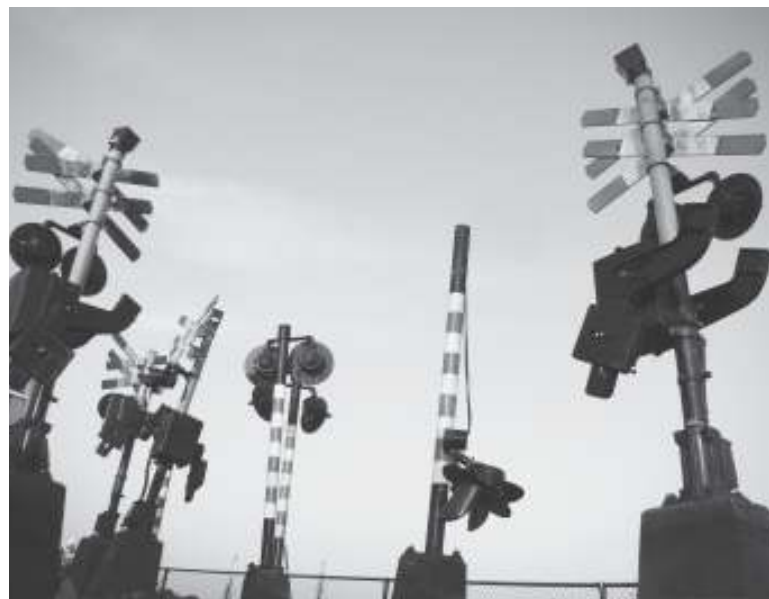
Het word stil in het Oost van Buitenpost. In het weekend van 19-20 november kon mem bij de spoorwegovergangen in Het Oost de bellen op zondagmorgen rond 0.30 uur voor het laatst horen klingelen. Niet alleen de betonplaten maar ook de knipperlichten en slagbomen werden verwijderd, ook werd er een stuk nieuwe rails aangebracht. Binnenkort komt er nog een hekwerk en word er een diepe greppel gegraven. De overbodige knipperlichten en slagbomen gaan naar de museumspoorlijn van de Stichting Stadskanaal Rail (S.T.A.R) in Stadskanaal. (foto: H.Boorsma)
