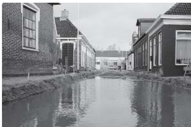
16 februari: Wonen aan het water in de Schoolstraat, om het zand goed in te spoelen wordt de afgegraven weg onder water gezet. Voor de aanwonenden is het moeilijk om met droge voeten in hun woning te komen. (foto: Hielke Boorsma)
