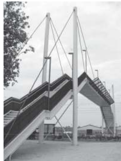
Voorbeeld van de brug over het spoor.
