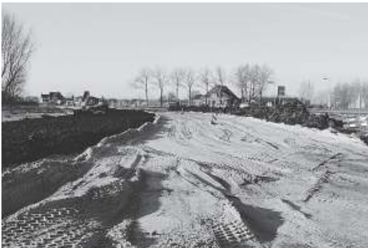
De werkzaamheden aan de weg bij Lutkepost richting Surhuisterveen zijn volop in gang. (foto: Hielke Boorsma)
