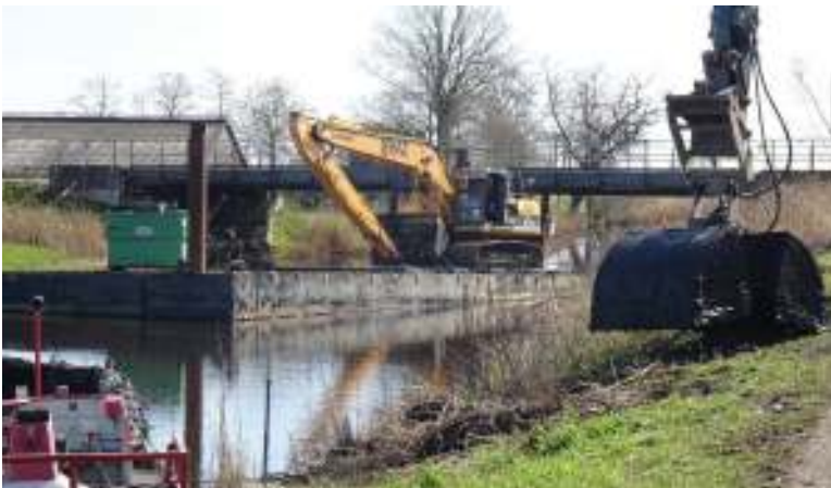
Het werk is begonnen met het uitbaggeren van de vaart ter hoogte van de spoorbrug.
