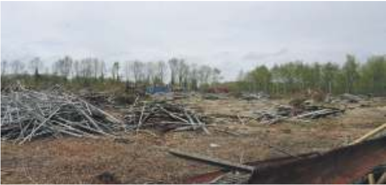
Sloop van de oude kassen aan de Keurloane. (foto: Hielke Boorsma)
