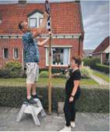
De eerste paal staat. (eigen foto)
