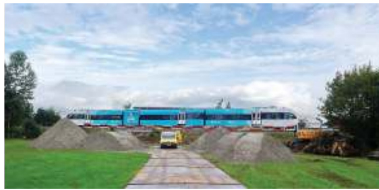
Reparatie bij het spoor ter hoogte van de verzakking. (foto: Hielke Boorsma).
