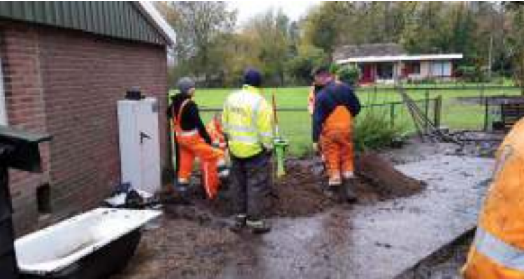
Er wordt geboord voor de netaansluiting. (foto: André van der Laaken)
