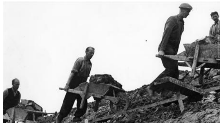
Gedwongen graafwerkzaamheden voor het maken van verdedigingswerken.
