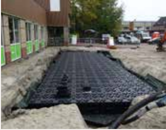
Om wateroverlast zoals op 20 mei 2024 te voorkomen werden er onder de parkeerterreinen infiltratiekragen geplaatst.
