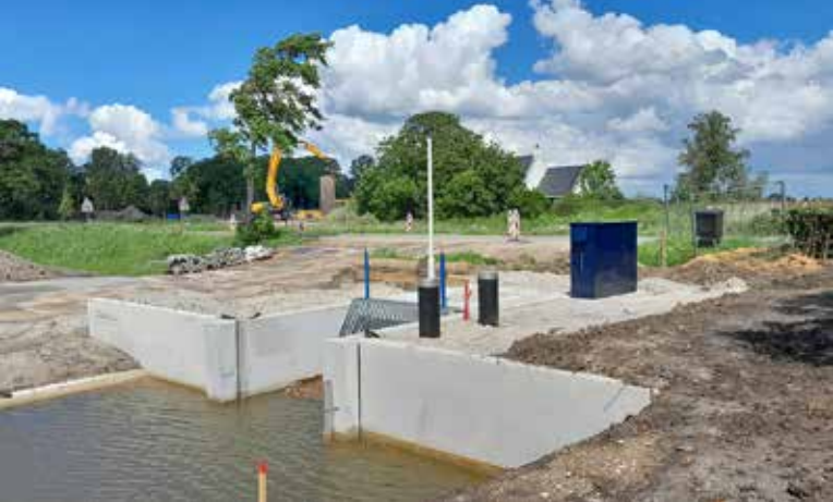
Het nieuwe gemaal aan de westkant van de Trekvaart, aan de Swadde. Op de achtergrond is het werk aan het oostelijke gemaal nog in volle gang.
