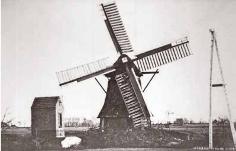
In februari 1925 verscheen deze foto in de regionale pers. Onder de kop ‘Drie soorten polderbemaling’ werd gemeld dat bij de Swadde drie soorten polderbemaling bij elkaar te zien waren. In het midden de oude windmolen, rechts ervan de windmotor (de ‘Amerikaan’) en in het kleine gebouwtje links de elektrische bemaling. Elektriciteit was er nog niet lang in onze omgeving. Tussen het huisje en de molen is het kerkje van Augsbuurt te herkennen. Rechts van ‘de Amerikaan’ het huisje van de machinist van het stoomgemaal.
