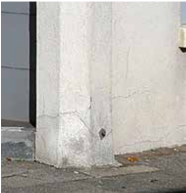
De ronde, metalen pen in de muur op de ‘Bakkershoek’ (hoek Voorstraat-Stationsstraat), die het Nieuw Amsterdams Peil in ons dorp markeert.
